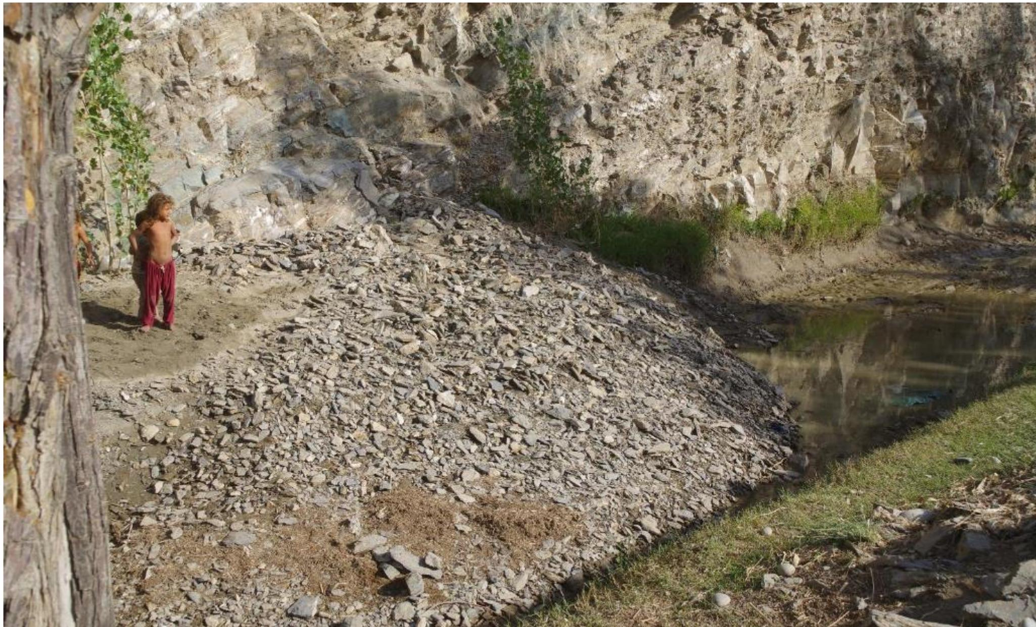
用水路は堆積土砂によって塞がれ、至る所で溢水した。集中豪雨の特徴は、短期かつ局所大量降雨であまりに電撃的、水門の開閉にゆとりを与えなかった。写真は5.5 km地点（スランプール）2018年10月14日
