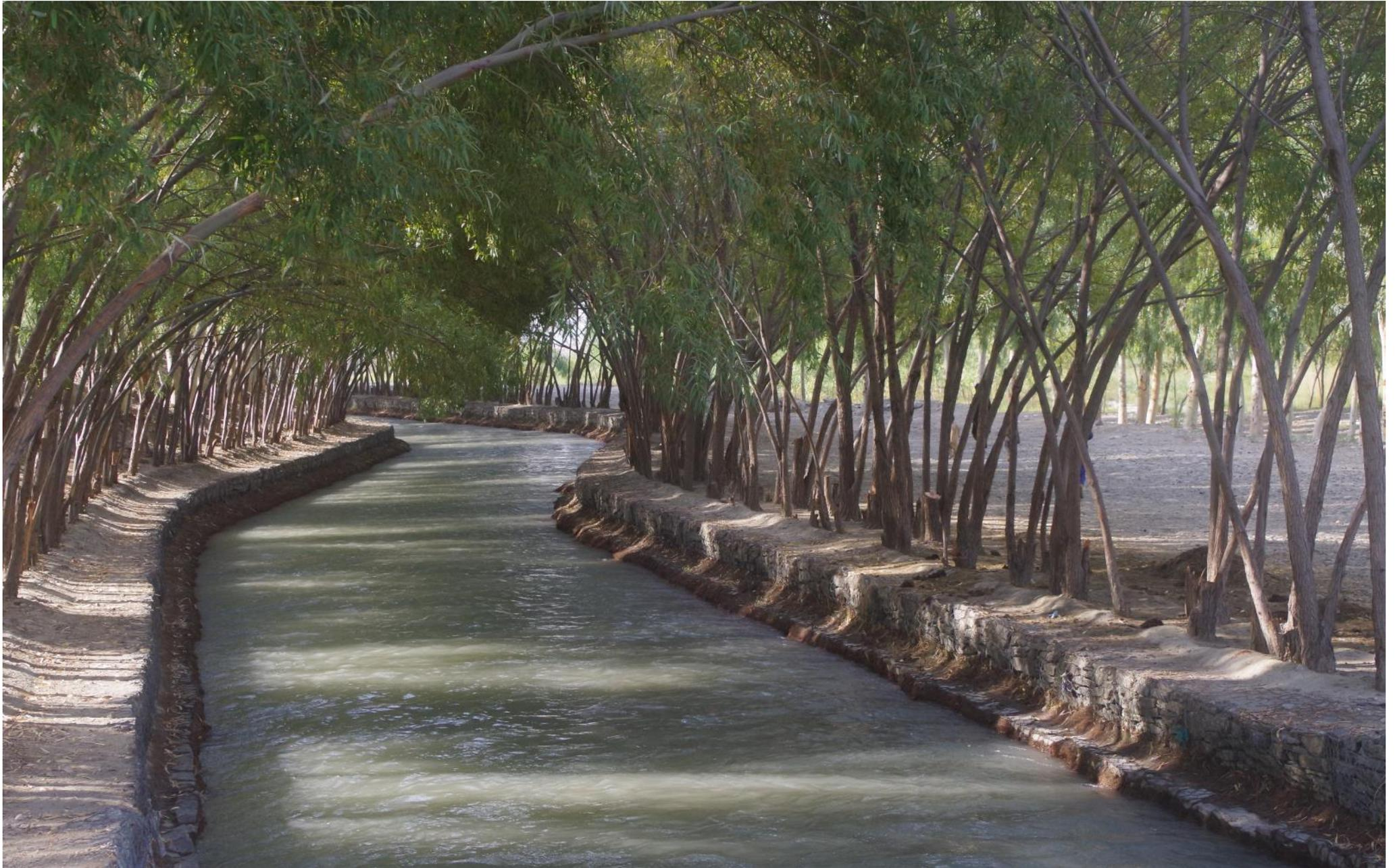
カマ第二堰の沈砂池の現在。最も良好な排砂効率を誇る。2018年10月13日
