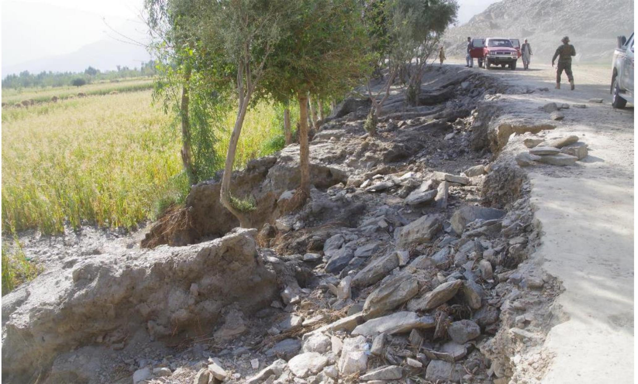
シギ堰の現状。上流側はダラエヌールからの土石流や鉄砲水の流路が隣接する。今回は流路の容量を超える水量が流れて溢れ、堰の上流側に流入、堰を埋め潰した
