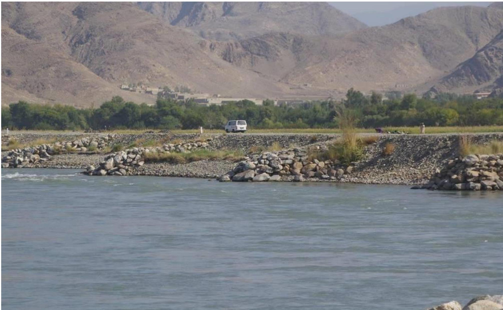
マルワリードII堰での第二期工事の主な洪水対策は、第一期工事に続き、浸食防止対策だ。方針・技術的な点は第一期と同じ。同部（カチャラ、コーティ、タラーン、ベラ村）は長年洪水に悩まされてきた地域だが、この地域の河道安定は下流域のミラーン堰の安定と一体である。また、ベラ村全域に灌漑が及べば、かなりの人口の帰農を促せる。8.5 kmの連続堤防はPMSとしては最長記録。なお、1.5 km～3.6 km間も未完成である。
