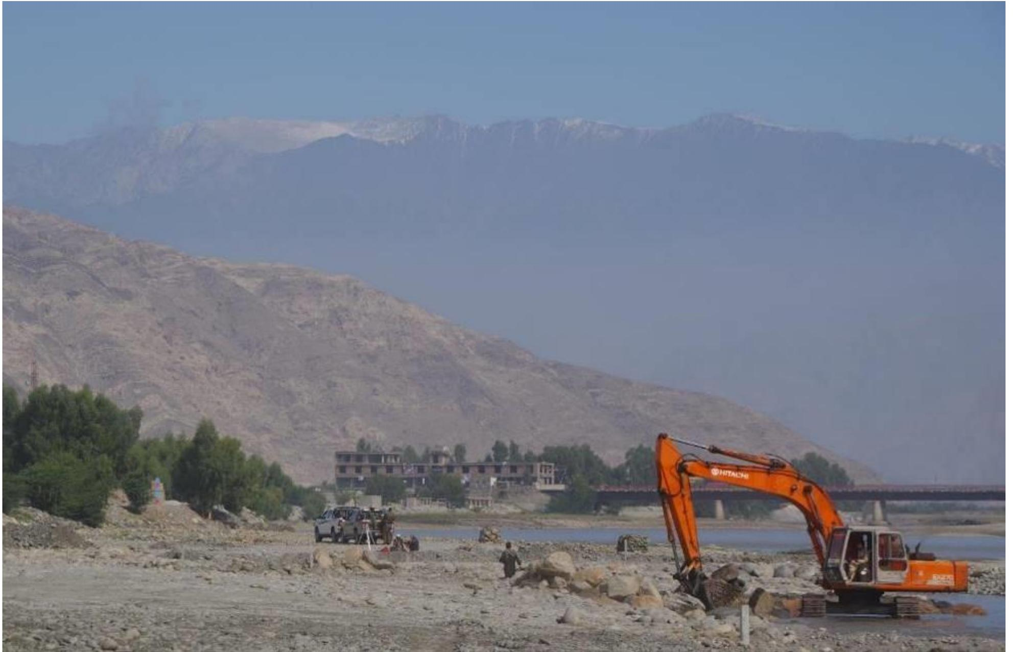
カマ第一堰と砂州との接合部。山田堰の立体形状は非常によくできている。水門側を急傾斜、対岸側を緩傾斜にしたもう一つの目的は、砂州＝堰接合部の保護だ。これまでの工事の経験から、洪水吐を砂州側に引き寄せて作り、同部の傾斜を緩やかに保つと、浸食が驚くほど少ない。また洪水吐の操作（幅の調整）で河道流量調整を図る際、アクセスが容易である。洪水吐は山田堰の南舟通しに相当する。ただし、使用する石材は膨大、石材輸送に焦点が絞られてきた。2018年10月16日
