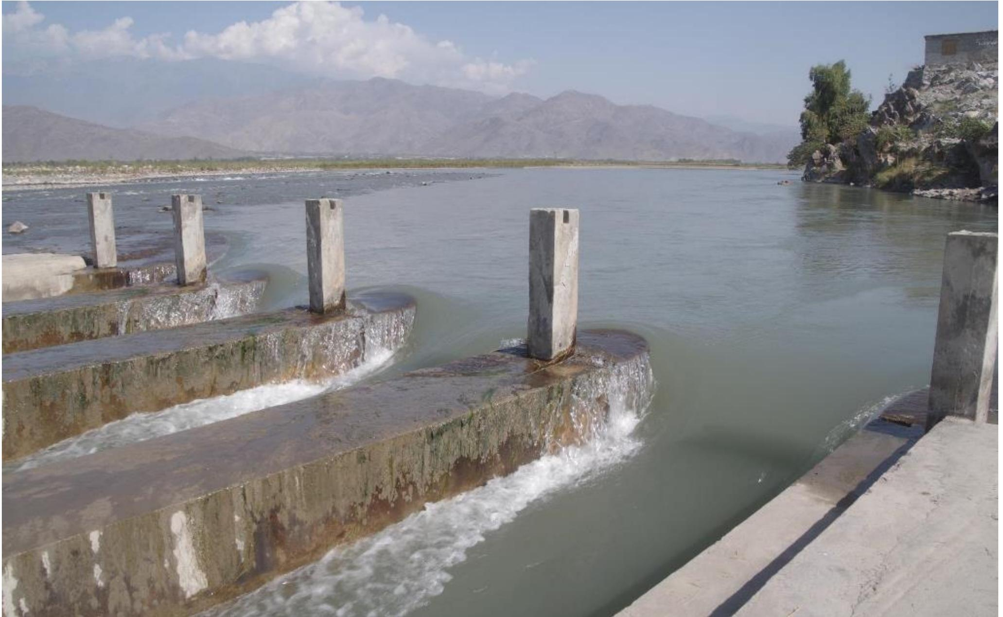
堰体表面の砂利は洗い流され、巨礫間を詰め、堰体が安定している。巨礫が堰表面に露出しているが各部の傾斜、洪水吐は良く保たれて機能している。表面の損壊は殆ど観察されない。2018年10月18日
