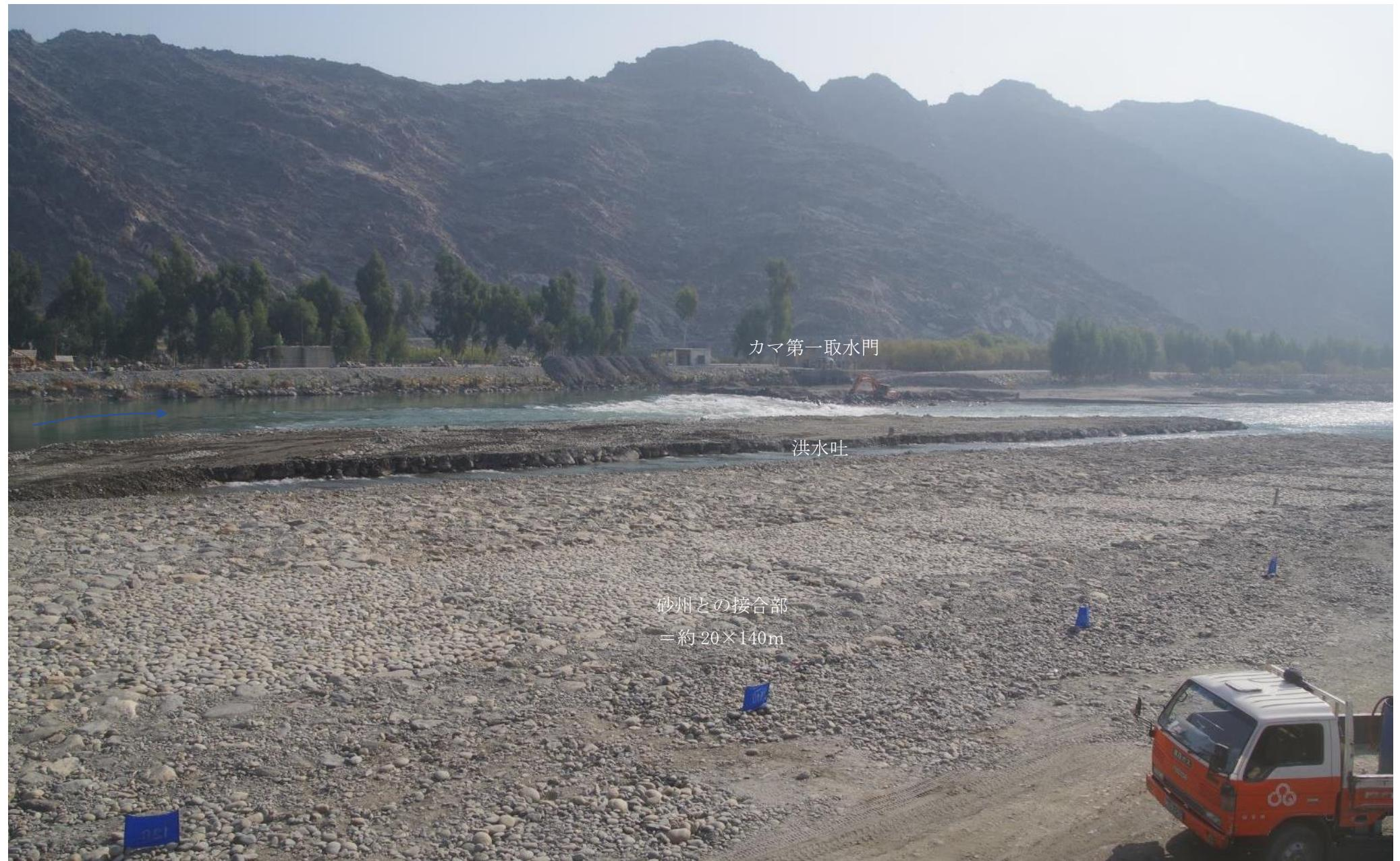
洪水吐の掘削風景。既に洪水吐そのものは両側の堰体と共に完成していたが、交通路確保のため砂利で埋立てていたもの。洪水吐の両壁は特大の巨礫を並べ、頑丈に作っている。2018年12月1日
