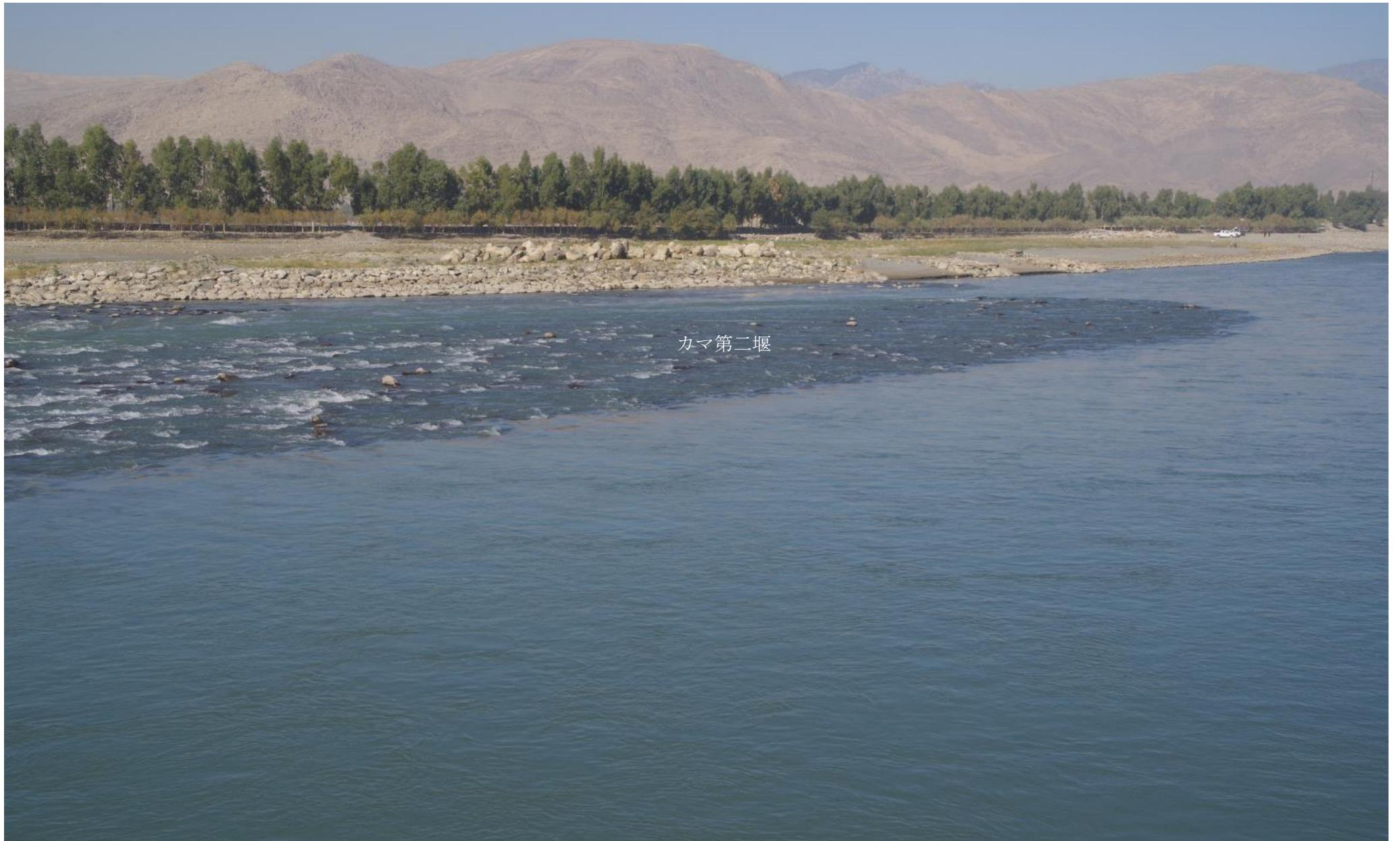
カマ第一堰はPMSが2008年に手がけた取水堰で、荒廃したカマ地方再建の口火となった。灌漑面積約2000ヘクタール、第二堰ほどではないが、「模範的な設備」としての意義も少なくなく、その後の改良点を大幅に加え、今回全面的な改修に踏み切った。堰幅210m、堰長45–140m、石張り面積約14,000 m<sup>2</sup>、落差1.2m
