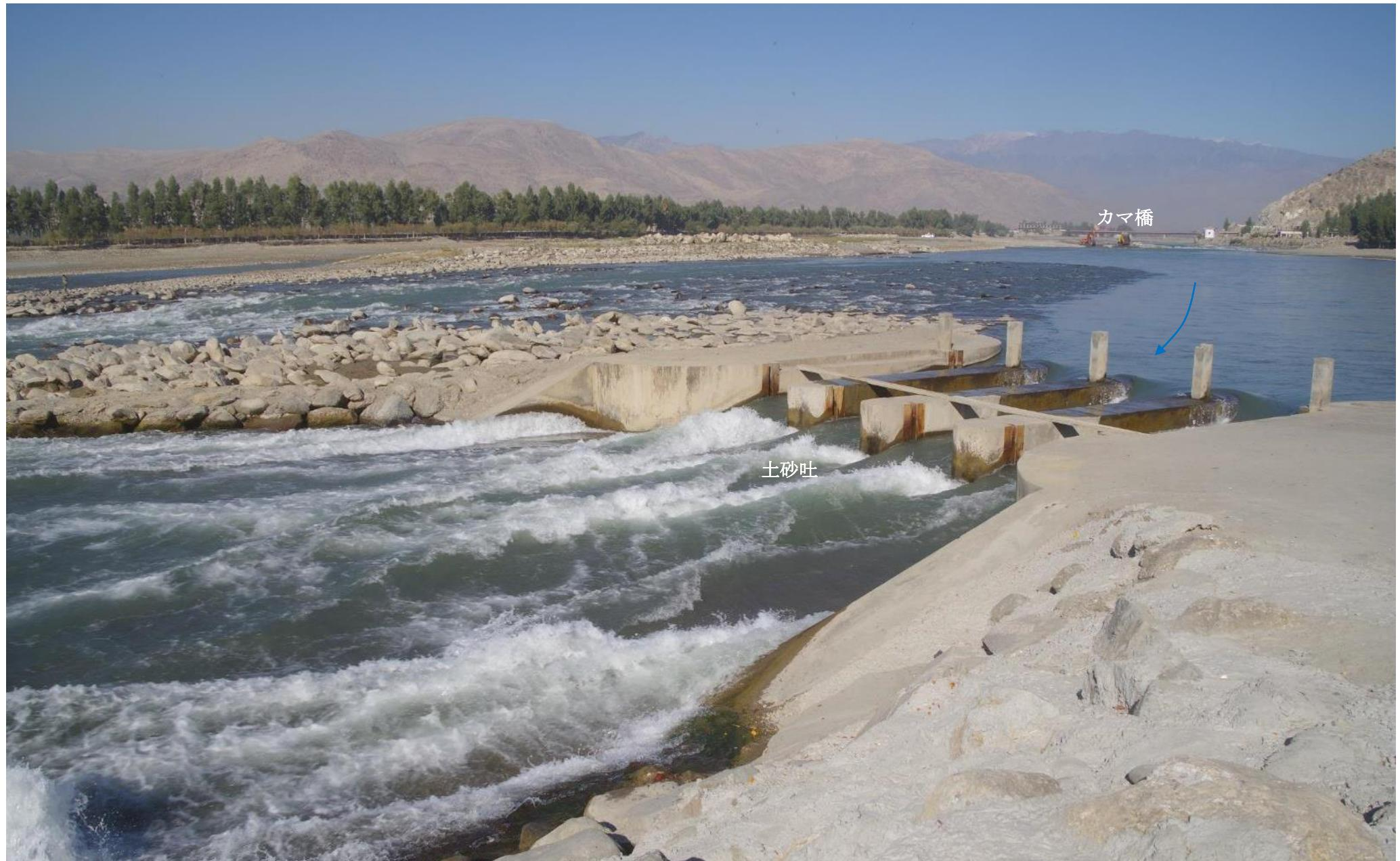
堰の巨礫表面に交通路確保で敷いた土砂利はきれいに流れ、美しいカーブを描く。中州側の堰長を長く緩やかにすることで、堰=砂州接合部の問題は本質的に解決を見た。また洪水吐は、浅く広い流れを中州側の緩やかな傾斜に造成することで安定を見いでいる。この知見がカマ第一堰でも生かされている。
