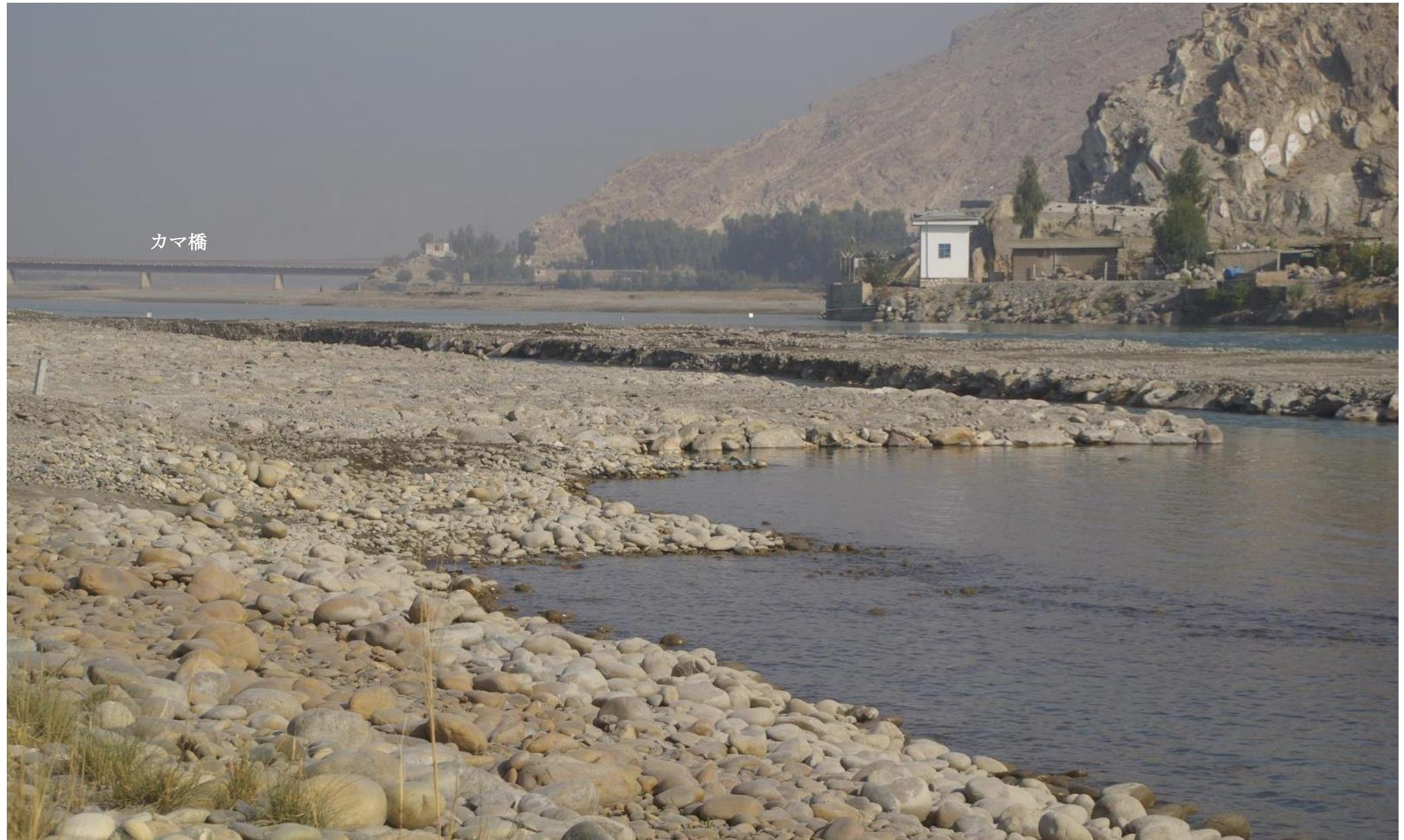
低水位期とは言えど大河である。堰造成で狭まった河道が激流となって下る。激しい洗堀が起きて深くなり、水深は5m以上。堰造成の工事で最も緊張を強いられる段階だ。2018年12月3日
