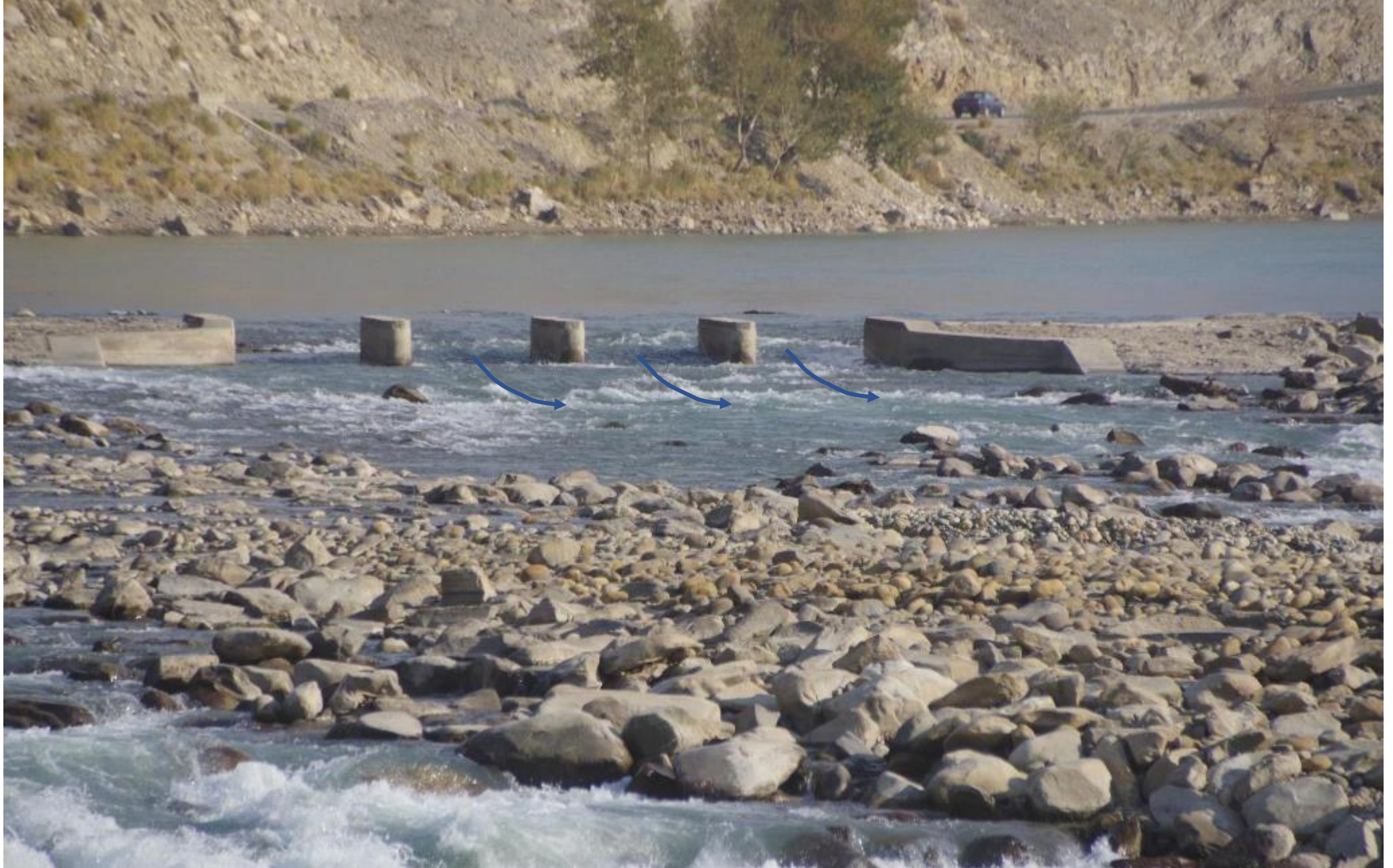
第3河道と鉄筋コンクリート製の土砂吐を遠望。現在採用しているものより大きい。損壊はなく、十分使える。2018年12月23日
