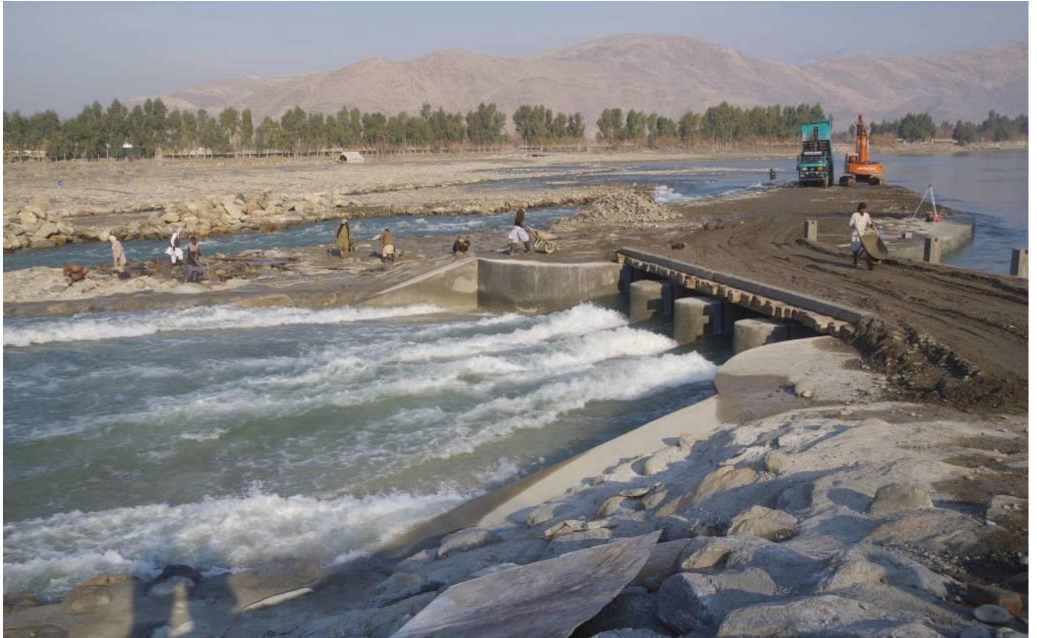
土砂吐の下流側。作業はまだ終わった訳ではない。2019年2月3日
