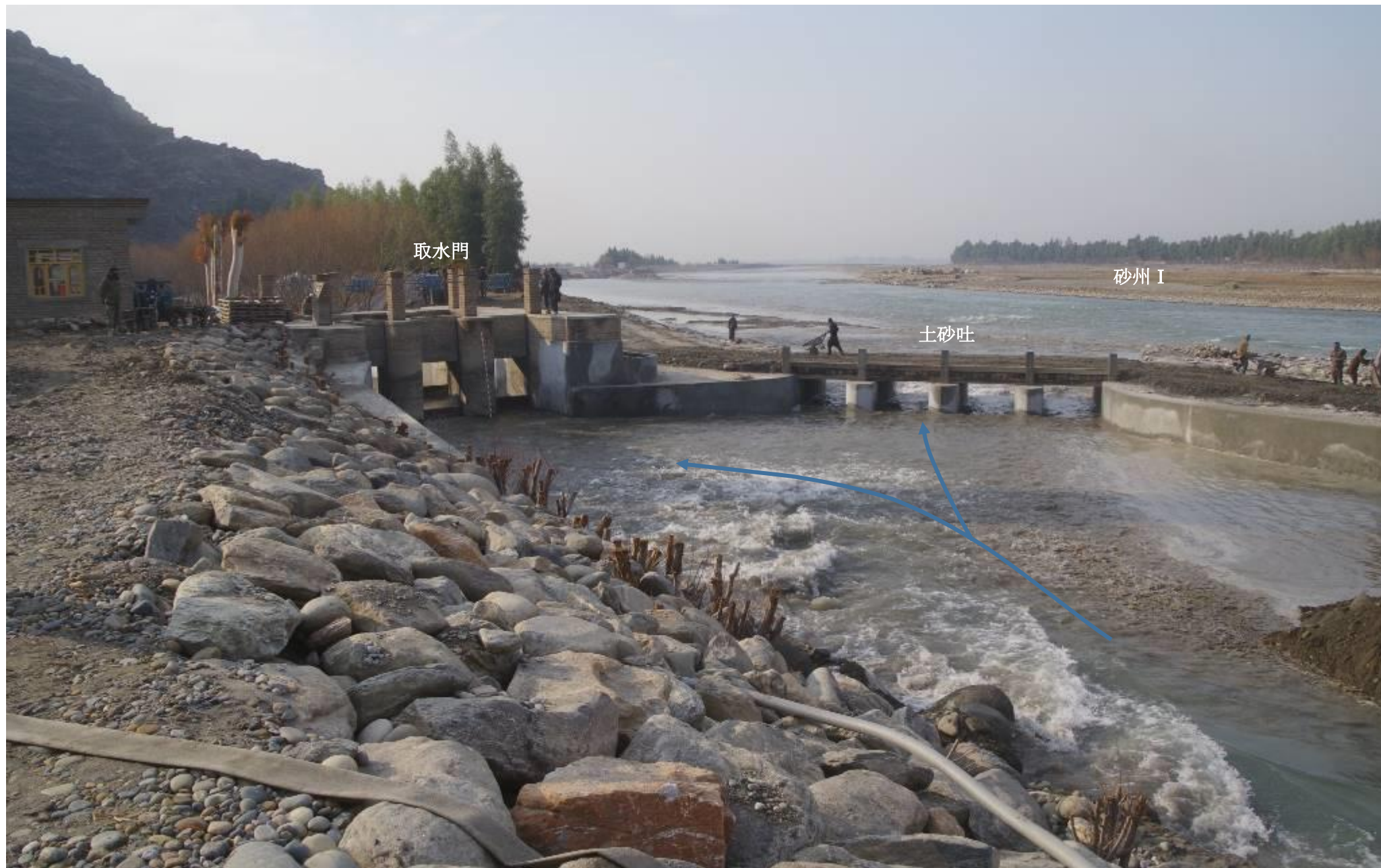
カマ第1堰開放直後、取水門と土砂吐を護岸上流側から見る。2019年2月2日
