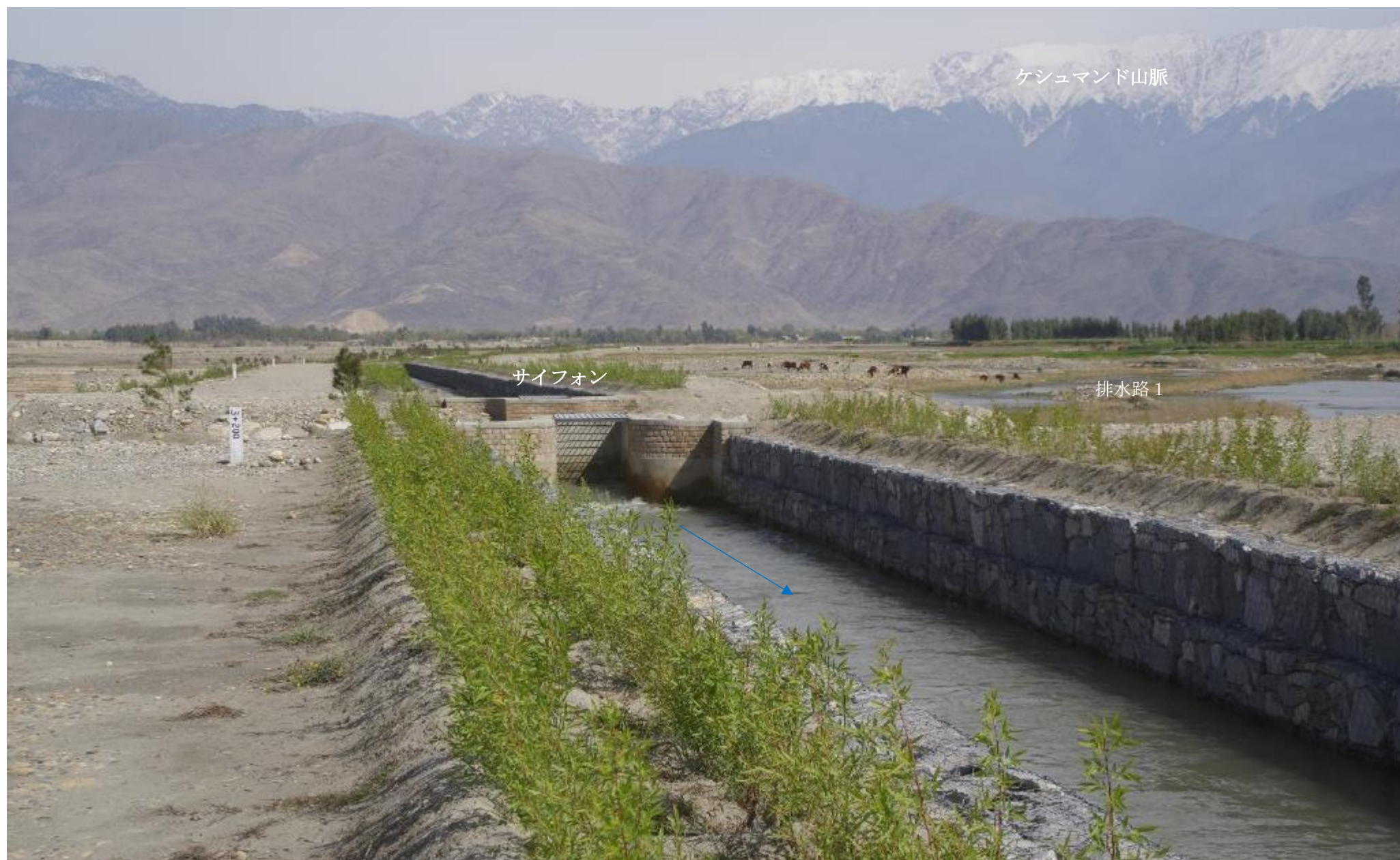
用水路 3.2 km地点のサイフォン周囲。植樹後約 6～8 ヲ月。2019 年 3 月 26 日
