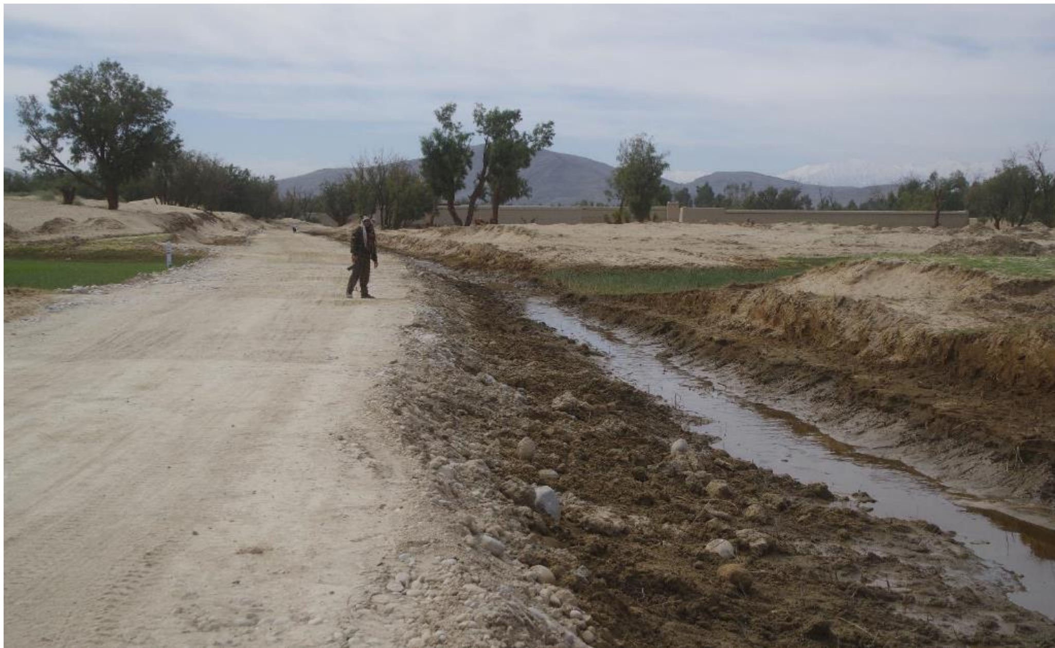
ガンベリ排水路・シギ分枝。工事地点は砂丘を片づけ、道路敷設の段階。約 900m地点を工事中。2019 年 4 月 6 日
