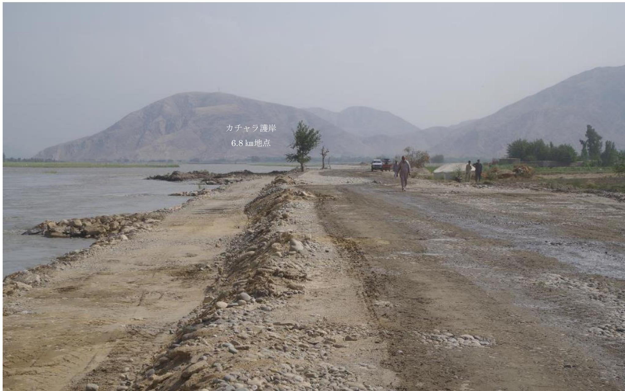
カマ第一堰、今夏最高水位の状態。この範囲はクナル河が最も狭まる地点で、川幅 200—250m、比較的安定しているマルワリード堰、カシコート堰が川幅 300m、極めて安定しているカチャラ堰、ミラーン堰が 1000m以上だ。2019 年 7 月 9 日
