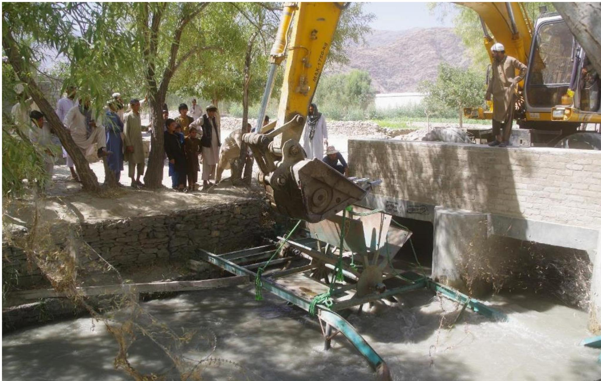
用水路E区。水の流れを悪くする割に揚水効率が悪い。水路床を破壊するため、回転力が弱まるからだ。再ライニング後に再検討して、適切な手段で揚水を考える。
