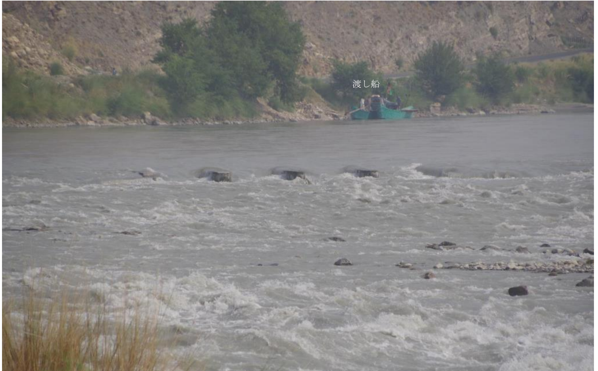
河道③にかかる土砂吐き。3mの溝4連。2019年9月23日
