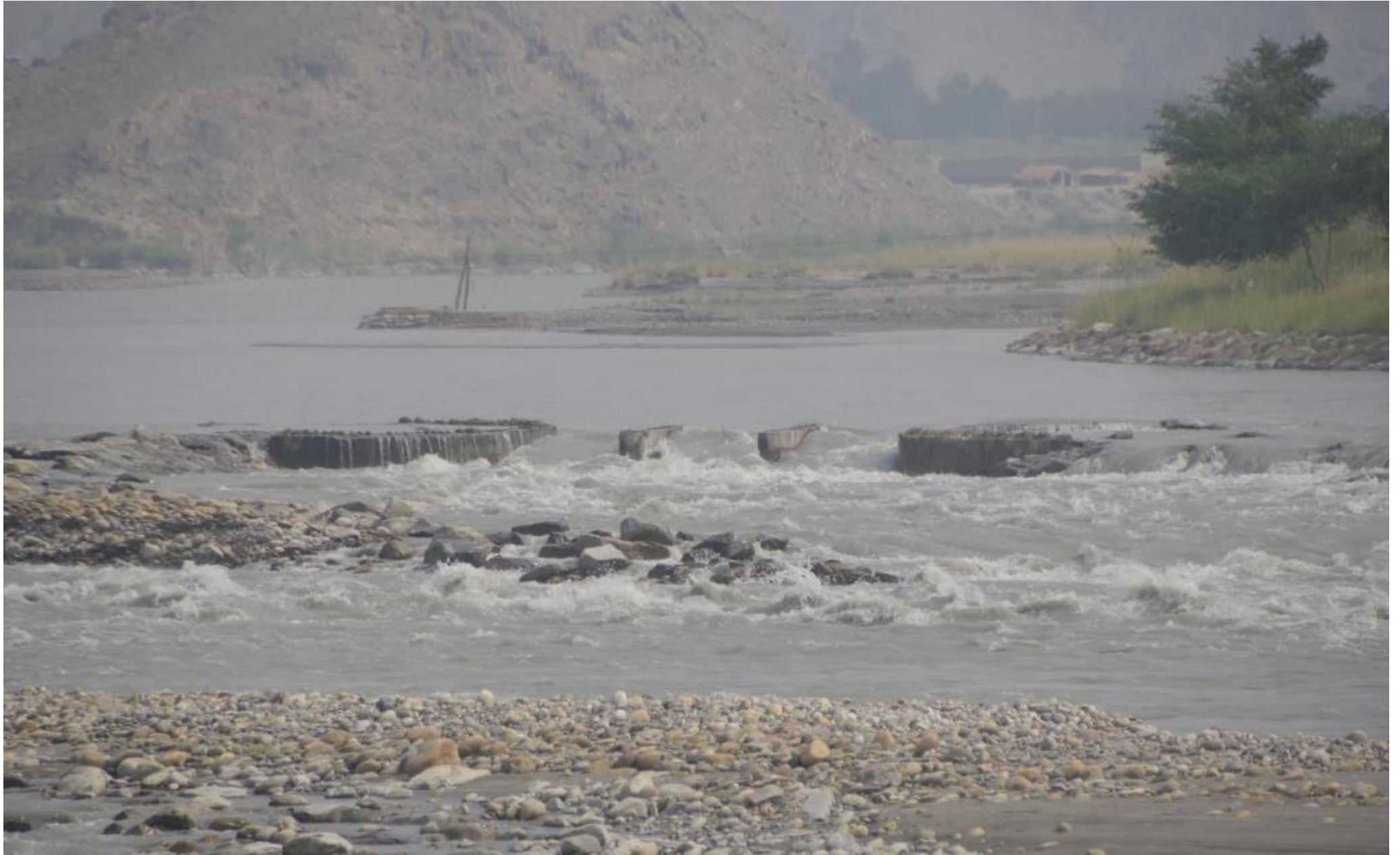
河道④の土砂吐。3m幅の溝が3連、PMS が最初に設置したコンクリート製の土砂吐き（2013年）。2019年9月23日
