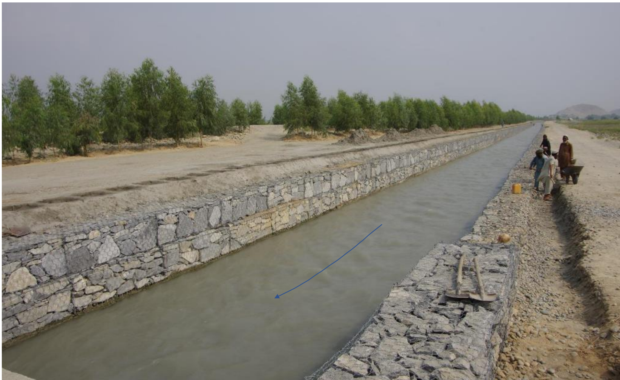
完成した 0.9～1.5 kmの主幹水路。植樹（柳枝工）が間もなく終了。2019 年 9 月 24 日
