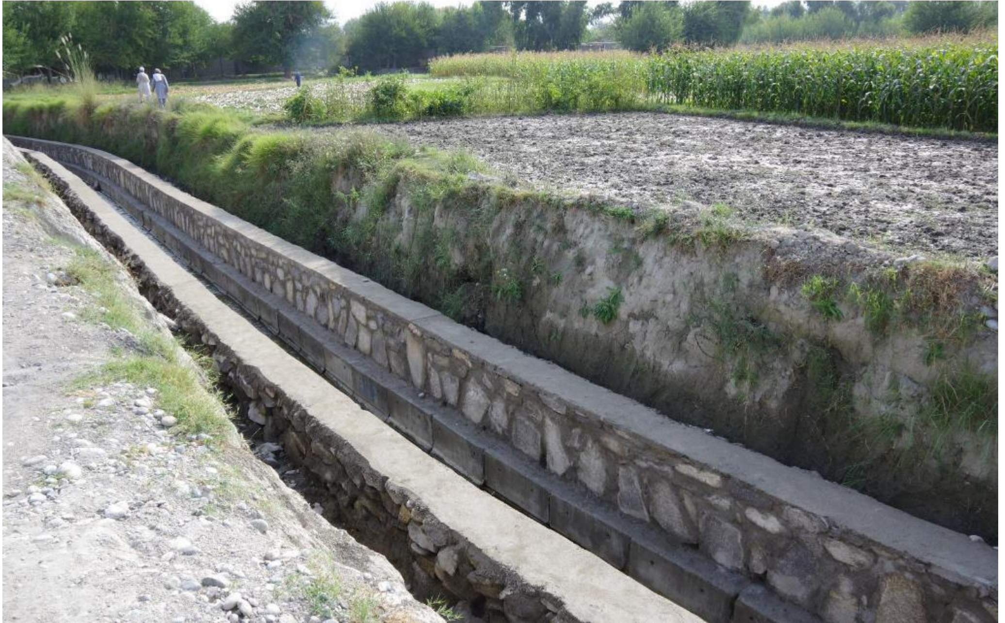
シギ分枝排水路、約 1700m地点。後は植樹を待つばかりだ。2019年 10月 1日
