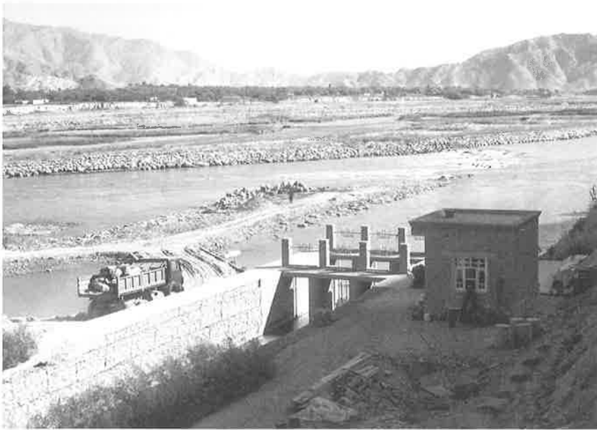
再開したバルカシコート堰建設。現場では至るところでPMS所有の重機がフル稼働している。 (2021年10月28日)
