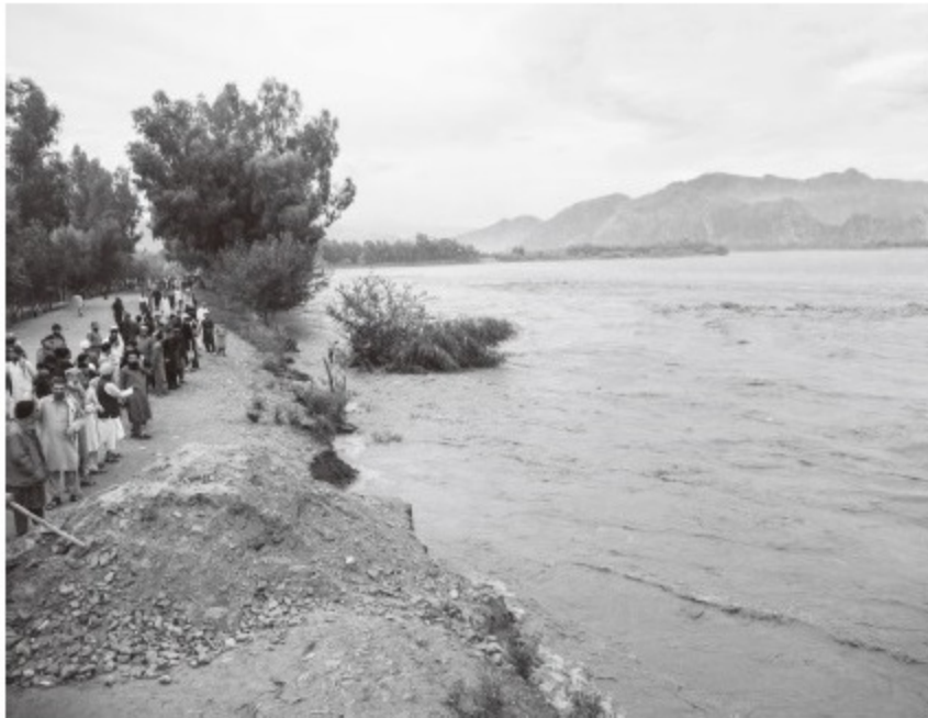
ベスード護岸線。洪水で大きく洗掘され、木が流されている。 (2022年8月27日)
