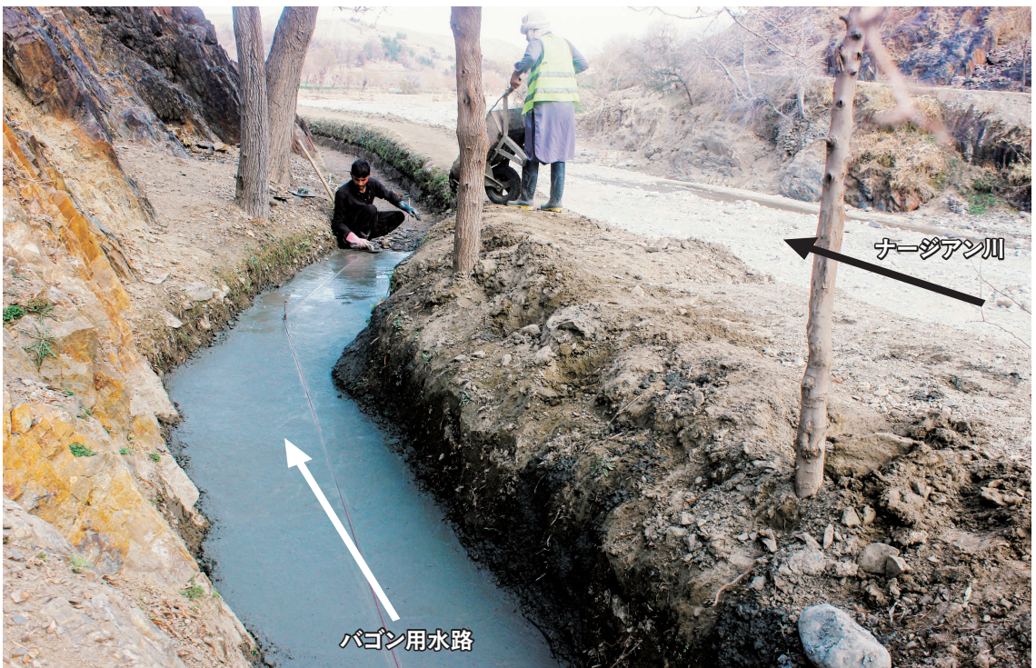
モラヘイル、カチコール、ミアガン用水路の整備が完了し、現場は最上流のバゴン用水路に移っている。ナー吉安事業は今年9月の完工に向け、バゴン地区での用水路と湧水路の整備を残すのみとなった。用水路は若手のワヒドゥラー技師が担当。(2026年2月17日)
