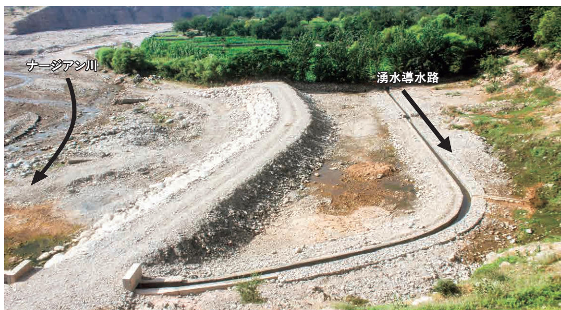
完成したバゴン地区の設備。上流に約10ヵ所確認されていた湧水を1つの水路に集め、用水路へ導く。(2026年8月5日)
