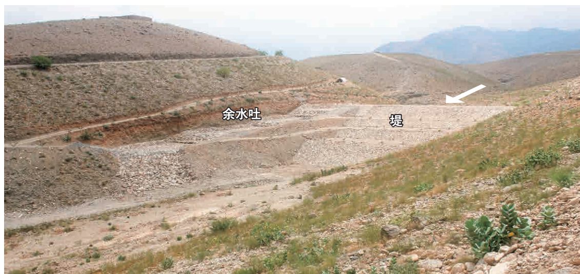
完成したギーダルナウ谷の砂防堤。上下流1ヵ所ずつ造成され、それぞれ22,000m 3 の貯水容量を持つ。ナージアン事業では、谷あいを流れ下る鉄砲水を緩流化させるため、盛土のほか、蛇籠、巨礫を用いた砂防堤が計8ヵ所造成された。(2026年8月12日)
