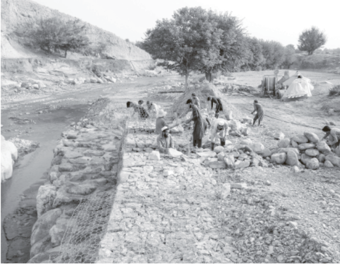
進行中のナージアン事業、取水門背面で護岸の蛇籠積みを行なう作業員たち。(2024年10月5日)
