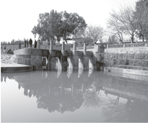
念願の増設が完了した、マルワリードI用水路の取水門。 (2024年1月24日)
